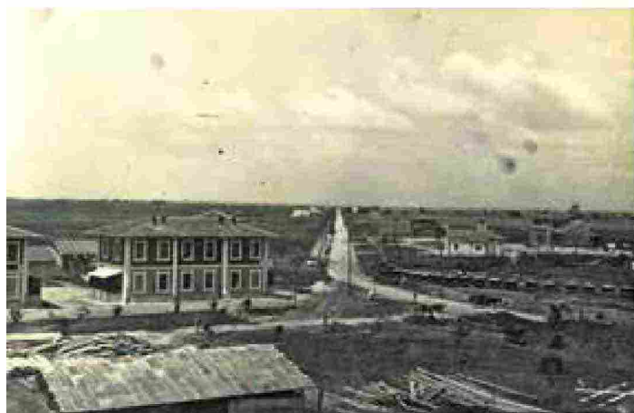
Giovanni Bortolotti. Bonifica pontina. Abbattimento delle strutture di Cancellorato di Quadrato per costruirvi Littoria (1932) Archivio del XX secolo, I atina
